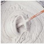
Colocar agua limpia en el balde. Luego agregar weber.col flexible blanco paulatinamente (5 litros por bolsa aprox) y mezclar manualmente o con un batidor eléctrico lento (500 rpm) hasta obtener una pasta homogénea.
